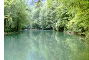
Bassin de retenue d'une petite centrale hydraulique dans le Canton du Jura
