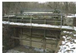
Prise d'eau sur la Venoge en cours de réhabilitation
