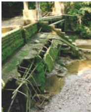
Barrage sur la Mentue (Cronay) avant sa réhabilitation
